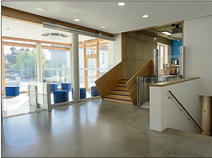
Ellipsium – Neubau einer Veranstaltungsarena in Holzbauweise mit Strohdämmung. Foyer Neubau mit Anbindung des ehemaligen Getreidespeichers.
